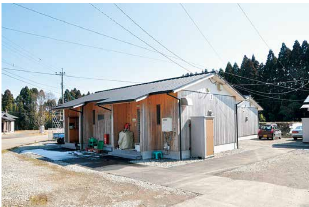
応急仮設住宅（現 原団地）
